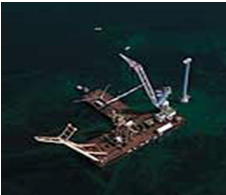
图 1：建设过程中的 Tunø Knob 海上风电场（1995 年建成）采用浮吊完成吊装工作
