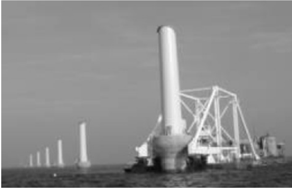
图 3：Barrow 海上风电场吊装情形
