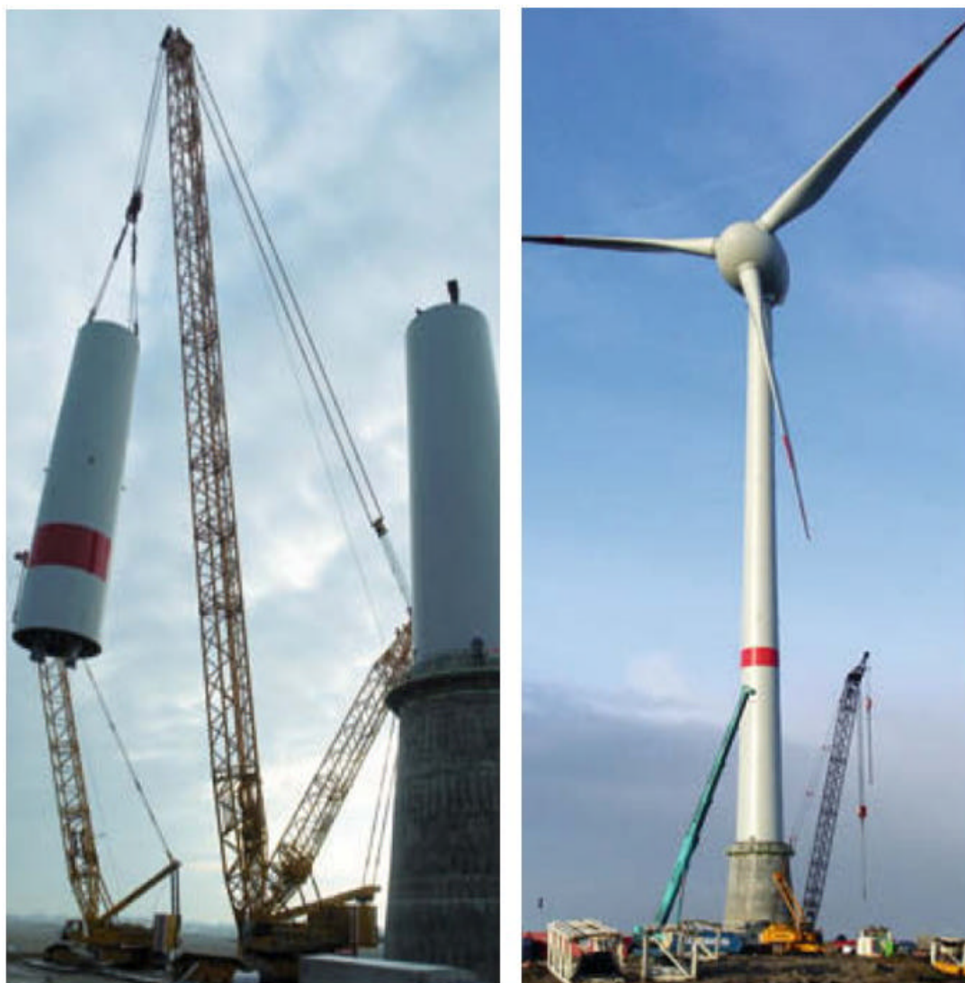
图 2：在 Cuxhaven 吊装 115 米高的钢制塔架部分 图 3：第三个安装完毕的 6MW 风机
