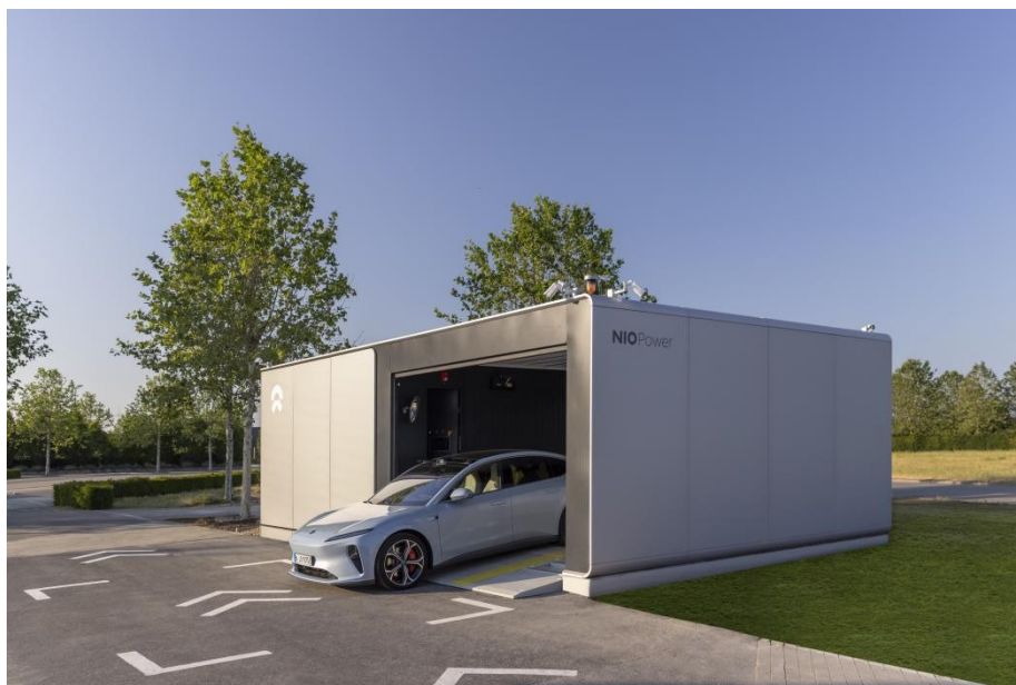
图 5 NIO 位于德国的换电站
